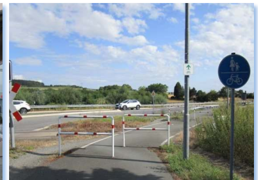
Umlaufgitter und Trampelpfad an Gambacher Straße
