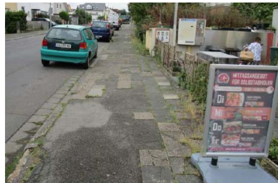
Schadhafter Belag und Einengungen auf der Hoch-Weiseler Straße (gem. Geh- und Radweg)
