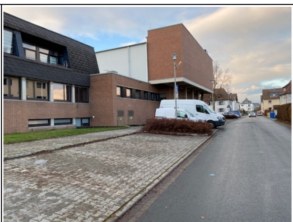
Ansicht Am Bollwerk
