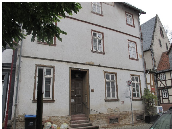
Schloßstraße/ Ecke Griedeler Straße
