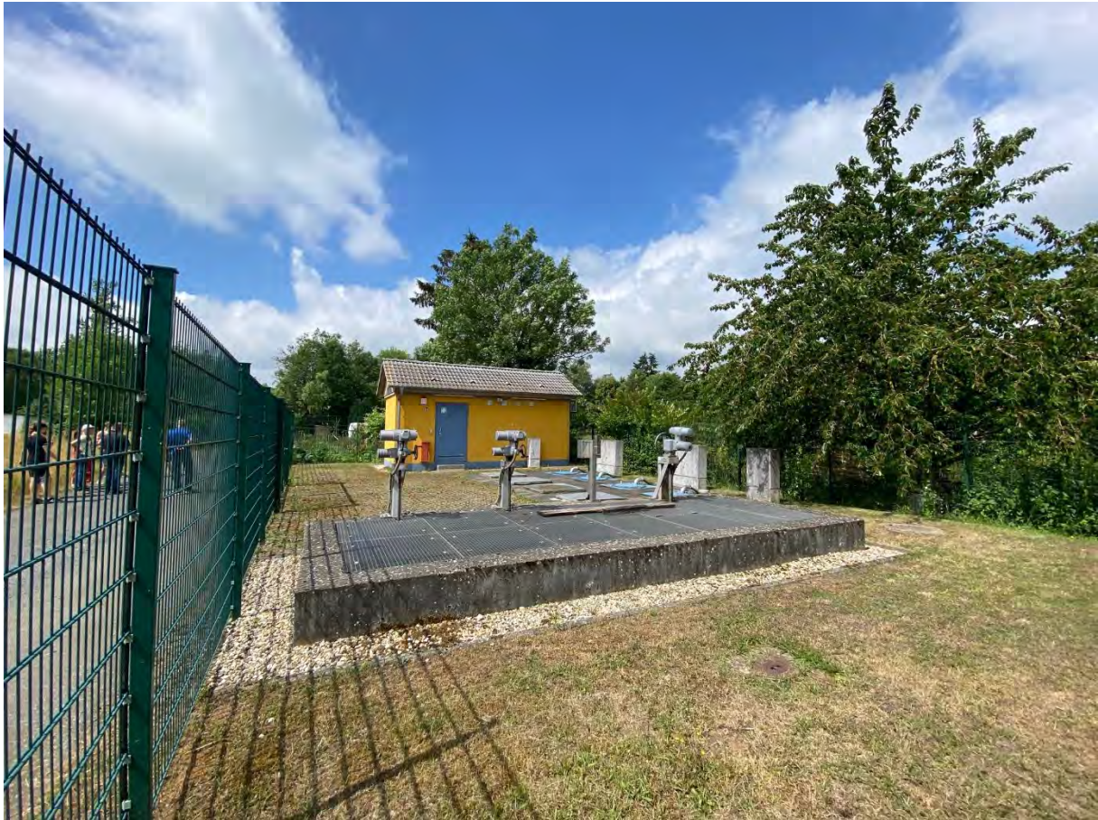
Pumpenhäuschen der EVB
